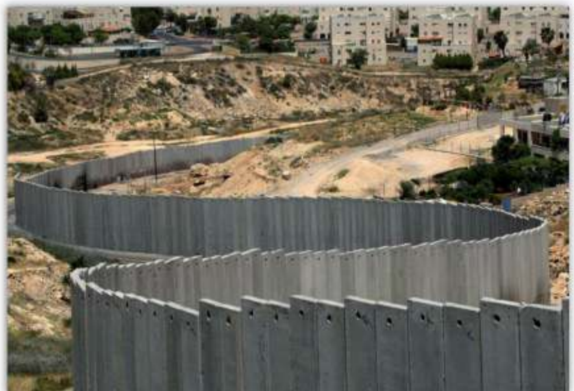
"מישהו יושב במרפסת ופתאום נשבר לו החלון, זה קורה בתדירות שבועית". מימין שועפט, משמאל פסגת זאב
